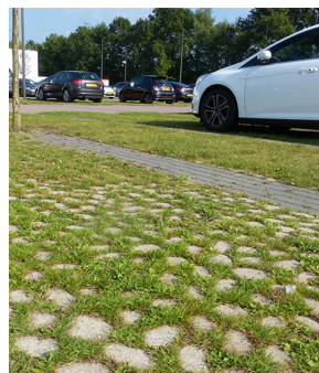
Parkeervlakken in grasbetonstenen.
