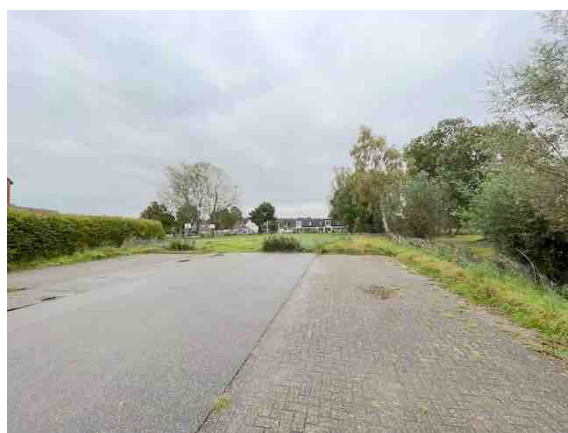
Figuur 5. Westkant van het terrein.
