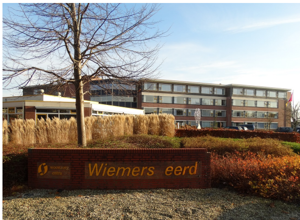
Figuur 7: Voorkant gebouw A.
