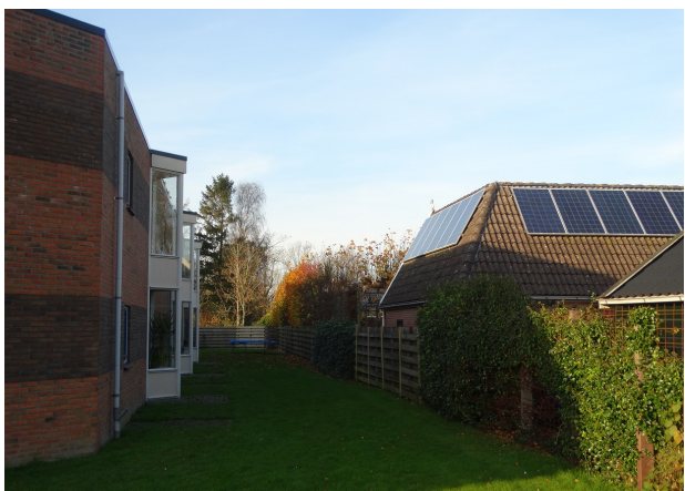
Figuur 5: Achtertuinen grenzen aan achterzijde gebouw C.
