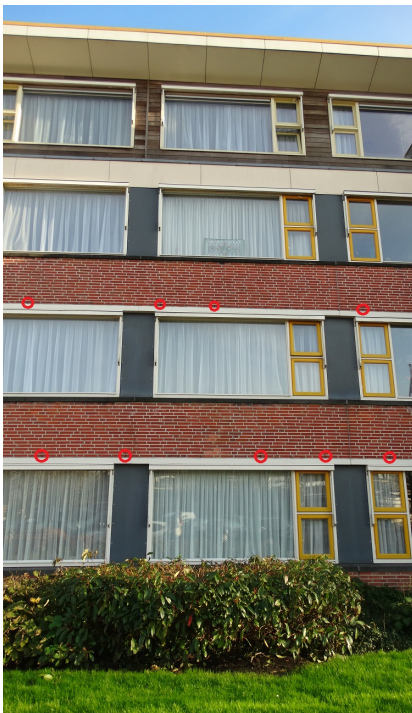
Figuren 19-21: Open stootvoegen aanwezig boven en onder ramen van gebouw A gezien vanuit de tuin. Brede open stootvoegen aanwezig op kopse kant gebouw A gezien vanuit de tuin. Hier tevens brede open ventilatievoegen op enkelhoogte (zie middelste foto).
