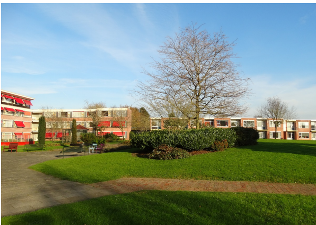
Figuur 27: Tuin met op de achtergrond gebouw A (links) en gebouw B (rechts).
