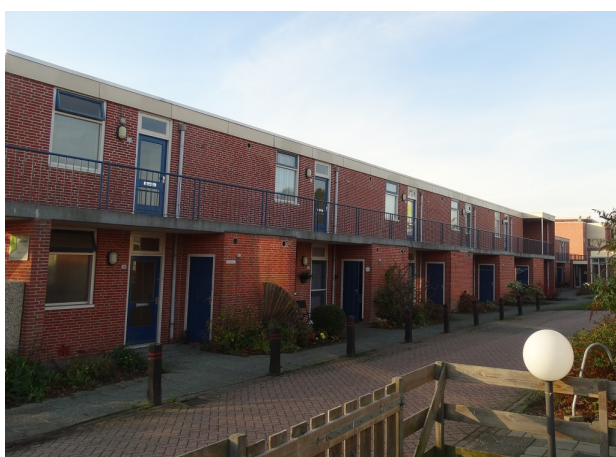
Figuur 11: Achterzijde gebouw B onder- en bovenwoningen.
