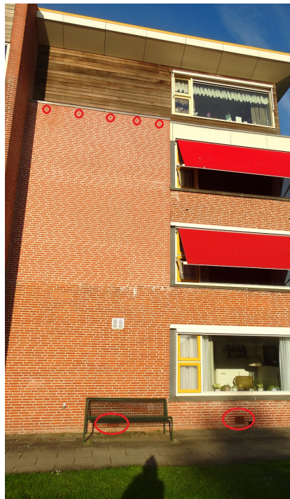
Figuren 19-21: Open stootvoegen aanwezig boven en onder ramen van gebouw A gezien vanuit de tuin. Brede open stootvoegen aanwezig op kopse kant gebouw A gezien vanuit de tuin. Hier tevens brede open ventilatievoegen op enkelhoogte (zie middelste foto).
