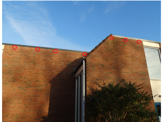
Figuur 23: Open stootvoegen aanwezig aan achterkant gebouw C. Figuur 24: Open stootvoegen op kopse kant gebouw C.
