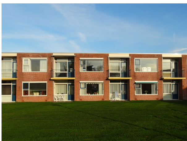
Figuur 12: Voorkant gebouw B onder- en bovenwoningen.
