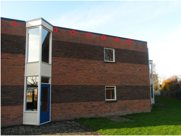
Figuur 23: Open stootvoegen aanwezig aan achterkant gebouw C. Figuur 24: Open stootvoegen op kopse kant gebouw C.
