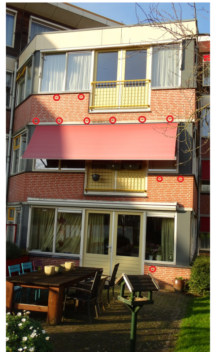
Figuren 19-21: Open stootvoegen aanwezig boven en onder ramen van gebouw A gezien vanuit de tuin. Brede open stootvoegen aanwezig op kopse kant gebouw A gezien vanuit de tuin. Hier tevens brede open ventilatievoegen op enkelhoogte (zie middelste foto).
