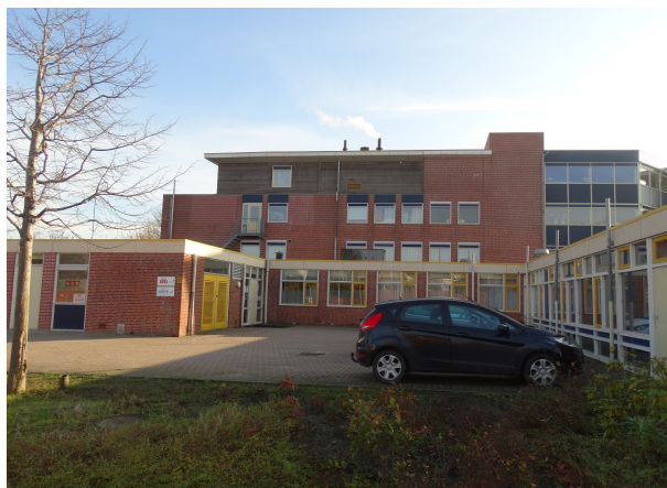
Figuur 8: Achterzijde gebouw A.
