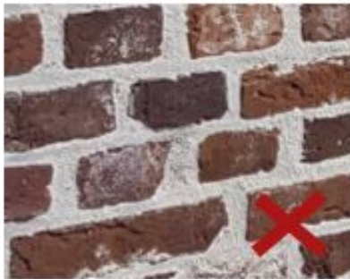
Nieuw metselwerk van oude steen met grove voeg van cementspecie
