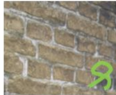
19 e eeuwse metselwerk met dunne platvolle voeg en dagstreep
