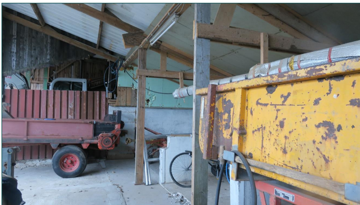
Figuur 2 De bebouwing wordt nog veelvuldig gebruikt als opslag.
