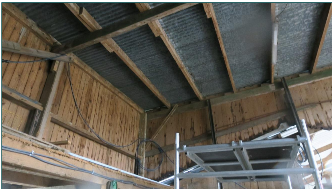
Figuur 3 De gebouwen hebben grotendeels geen dakbeschot.
