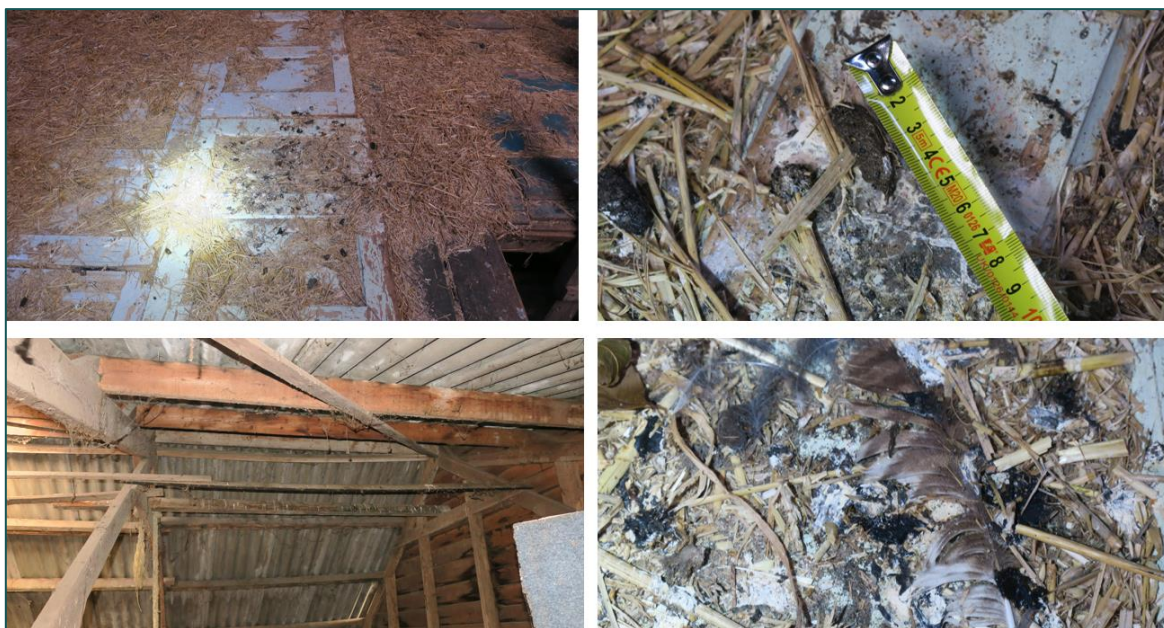
Figuur 3.2 In de op termijn te slopen schuur zijn meerdere sporen van een steenuil waargenomen, tevens is er een steenuil waargenomen tijdens het veldbezoek.
