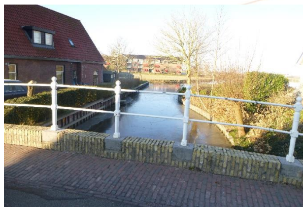
Brug aan de Groeneweg (foto richting west)
