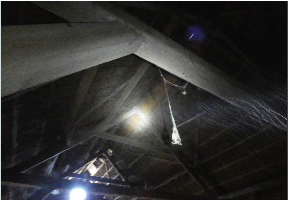
Figuur 3.1 Potentiële wegkruipruimten en hangplekken voor vleermuizen in de hooizolder van de woning.
