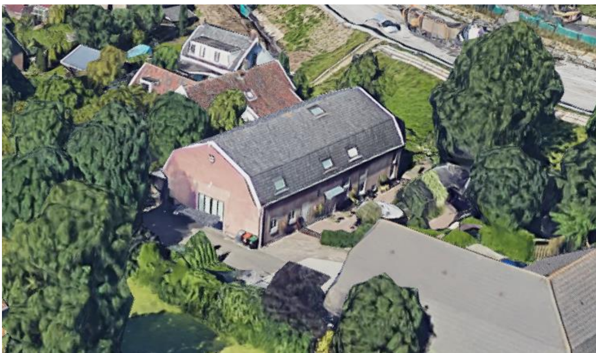
Afbeelding 5: Woning Lekdijk 384 te Nieuw-Lekkerland
