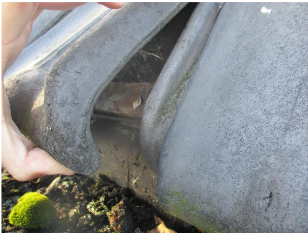
Figuur 2 De dakpannen sluiten netjes aan op de houten constructie, waardoor de ruimte tussen dakpan en dakbeschoot niet toegankelijk is voor huismussen.
