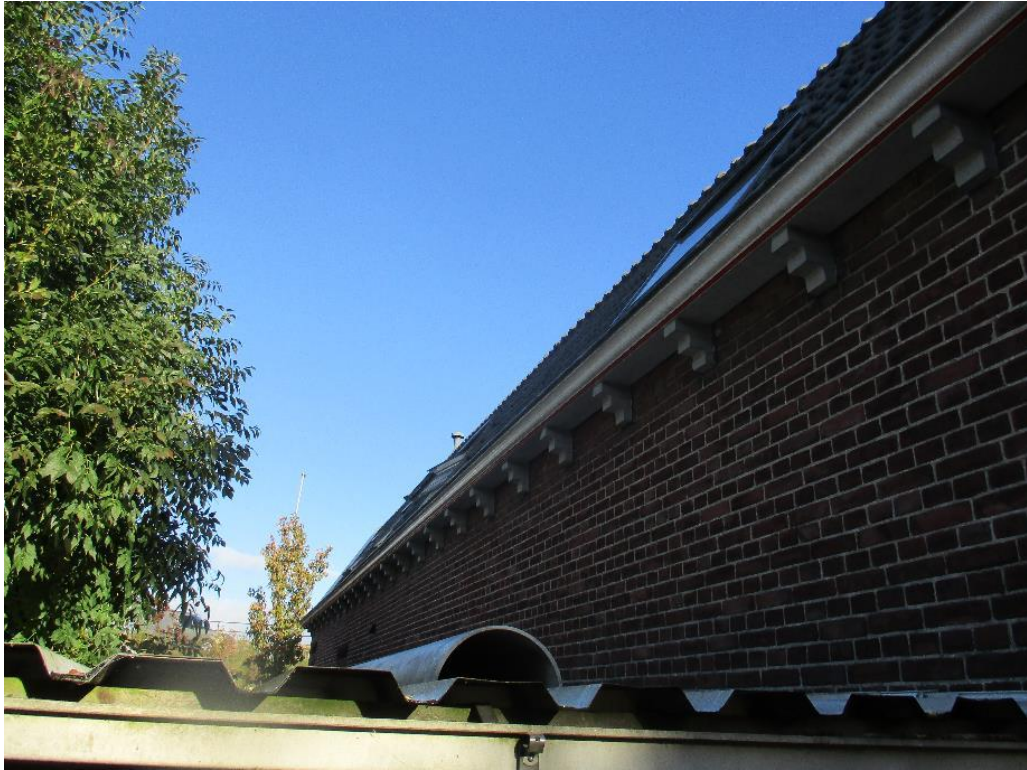
Figuur 3 Er zijn aan de gevels en het dak geen openingen aangetroffen waar het aannemelijk is dat gierzwaluwen, huismussen of vleermuizen gebruik van (kunnen) maken.
