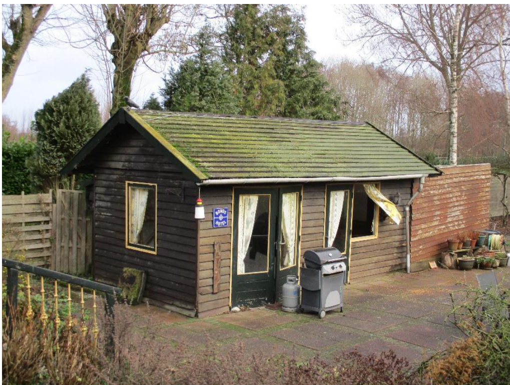
Figuur 2 Zij aanzicht van de te slopen schuur
