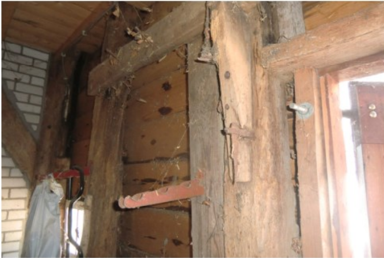
40 Moderne kozijnen zijn geplaatst tussen het historische stijl- en regelwerk van de rechter zijgevel.
