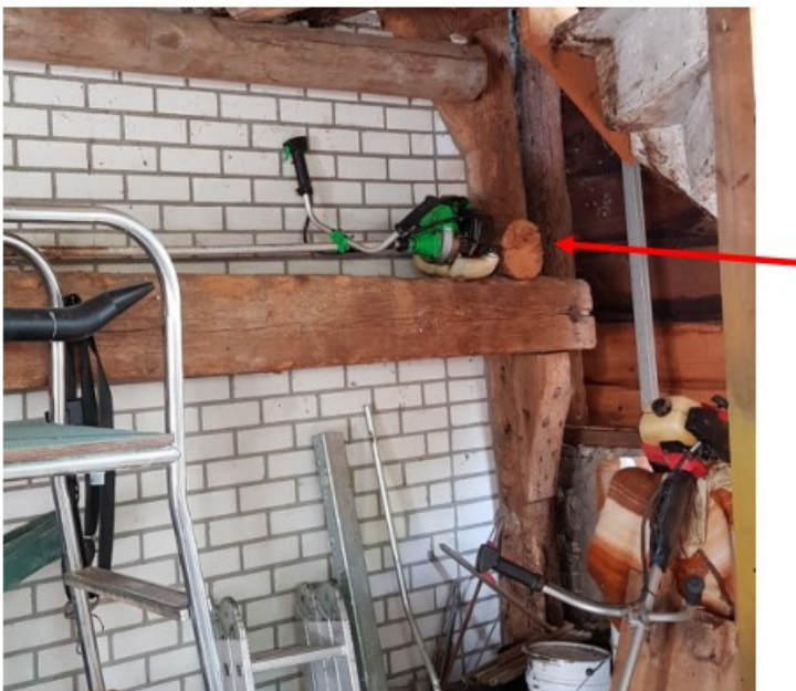
35 Een restant gebintstrijkbalk met hierop nog een restant vloedzolderbalk (pijl). Hierboven een hergebruikte telefoonmast waarmee de balklaag wordt gedragen die voor de hergebruikte tweekwartentrap (uiterst rechts) is verlaagd.
