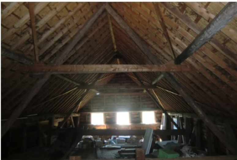
42 De kap met het zicht op de achtergevel. In 1986 is het dak vervangen.
