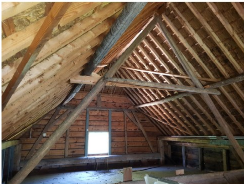
43 De kap met het zicht op de voorgevel.
