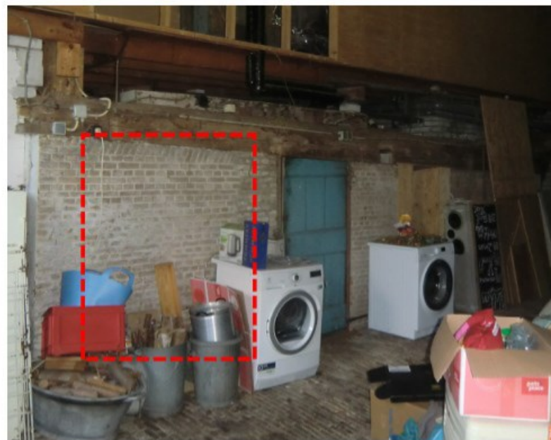
Figuur 2 in kader: restanten van een dichtgemetselde deur; op traditionele wijze onderstroomd onder de balk (schuine metselsteentjes).
