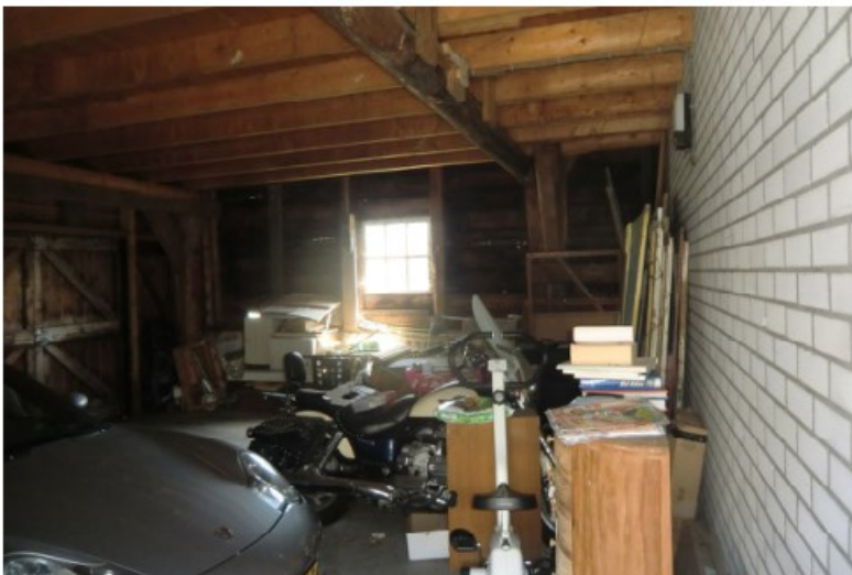
36 Overzichtsfoto van de het voorste compartiment / het garagegedeelte met het zicht op de linker zijgevel.
