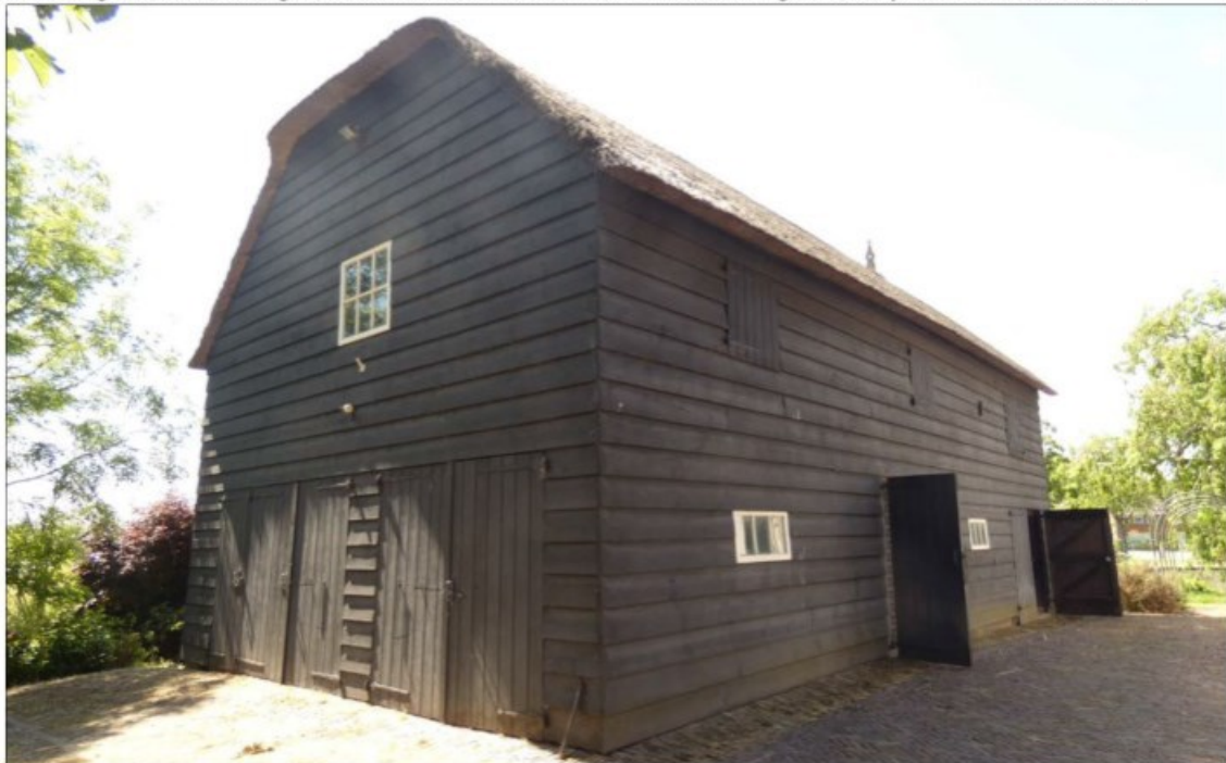
Afbeelding II: noord en westgevel van de karakteristieke schuur naast de woning aan de Peperstraat 48 te Oud-Alblas
