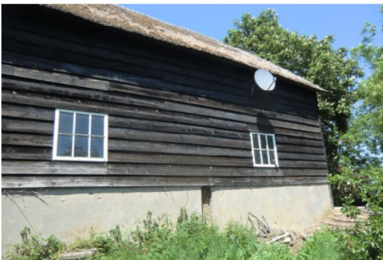
26 De linker zijgevel. Boven de keermuur zijn al het potdekselwerk en de vensters in 1986 vernieuwd.
