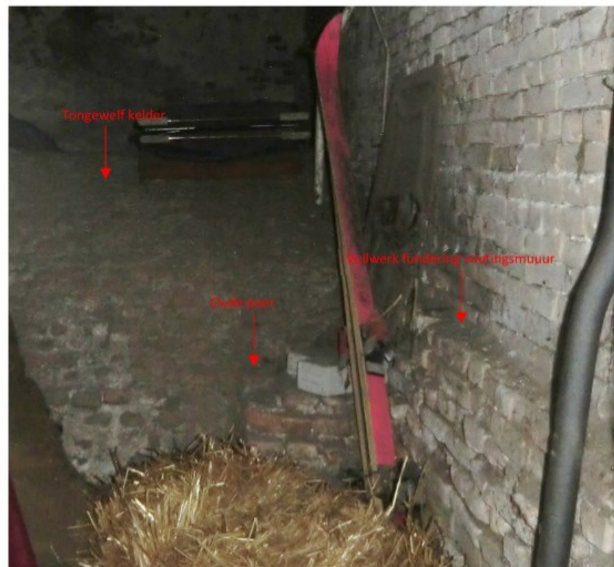
Figuur 3 Bovenzijde kelder met aangegeven oude bouwsporen
