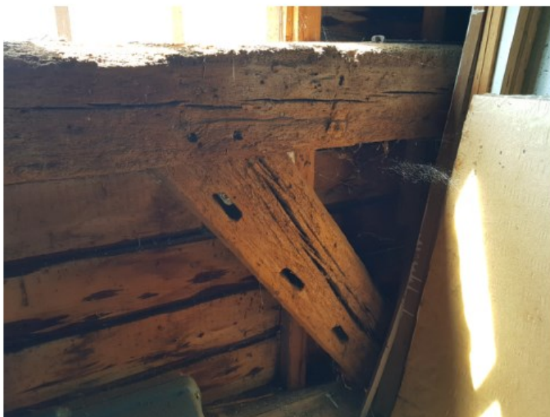
45 Bij het achterste gebint is het korbeel bij de rechter zijgevel gemaakt van een hergebruikt onderdeel van een gesloopte hooiberg. Dit is te zien aan de langwerpige sleufgaten waar bij een 'laan' van de hooiberg de sporen doorheen staken.
