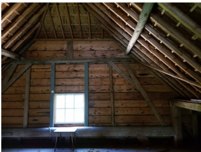
44 De voorgevel met aan de binnenzijde een gebint met een jukspant.
