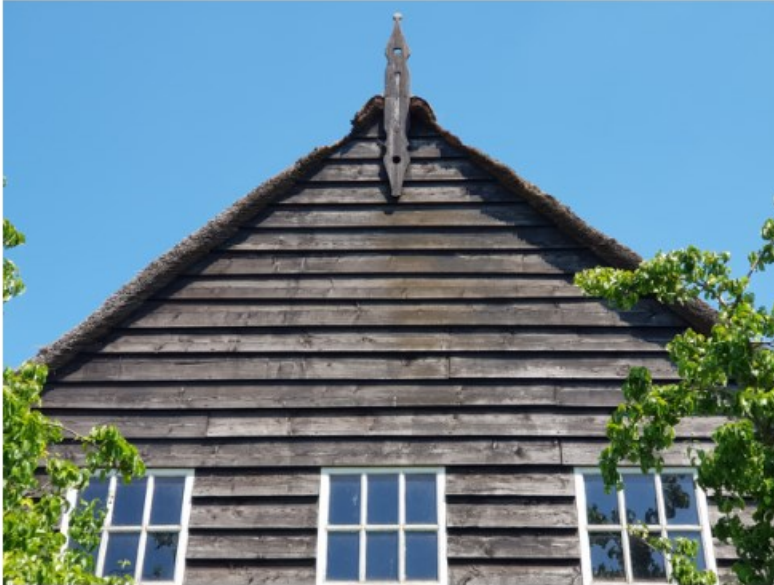
24 Drie zesruit vensters op de verdieping voor daglichttoetreding voor de zolder.
