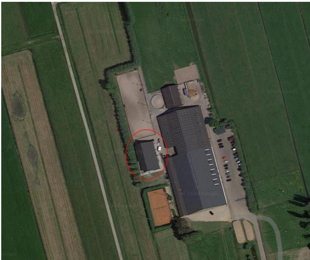
Afbeelding 3: Bestaande gebouw Overslingeland 5A Noordeloos
