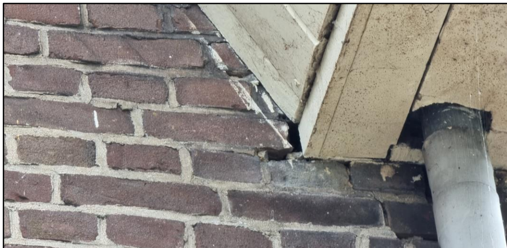
Figuur 4 De aansluiting van de gevel op het overstek en de dakgoot van de woning.
