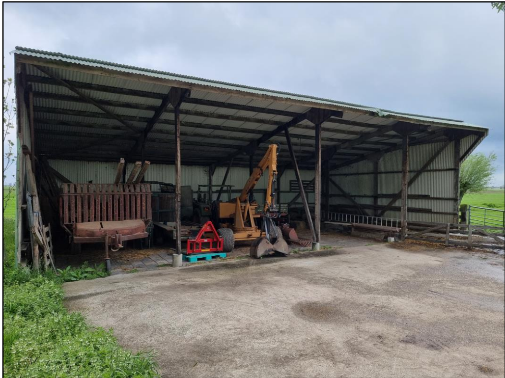
Figuur 3 De te saneren kapschuur op de planlocatie.
