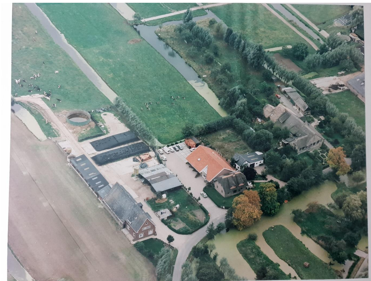
Figuur 2.3: Situatie Zuidzijde 94 en 96, voordat de loods geplaatst was.
