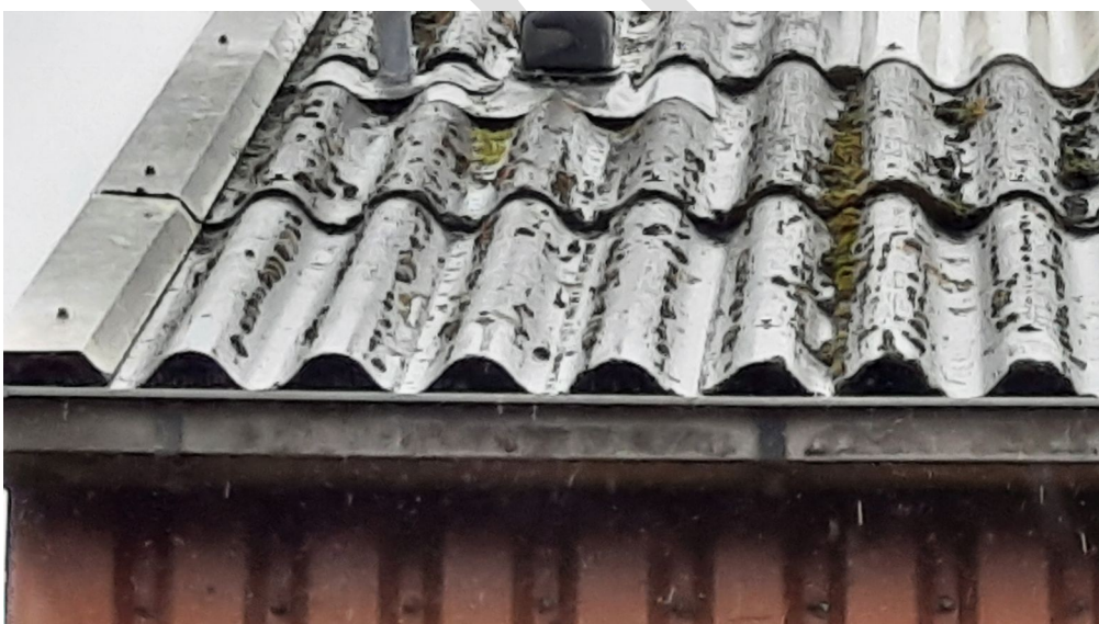
Ook het golfplaten dak van het zuidelijke pand aan de Zuidzijde 96 is geschikt voor vaste rust- en verblijfplaatsen van huismus. Foto: M.M. Bouwmeester | Ecoresult B.V.
