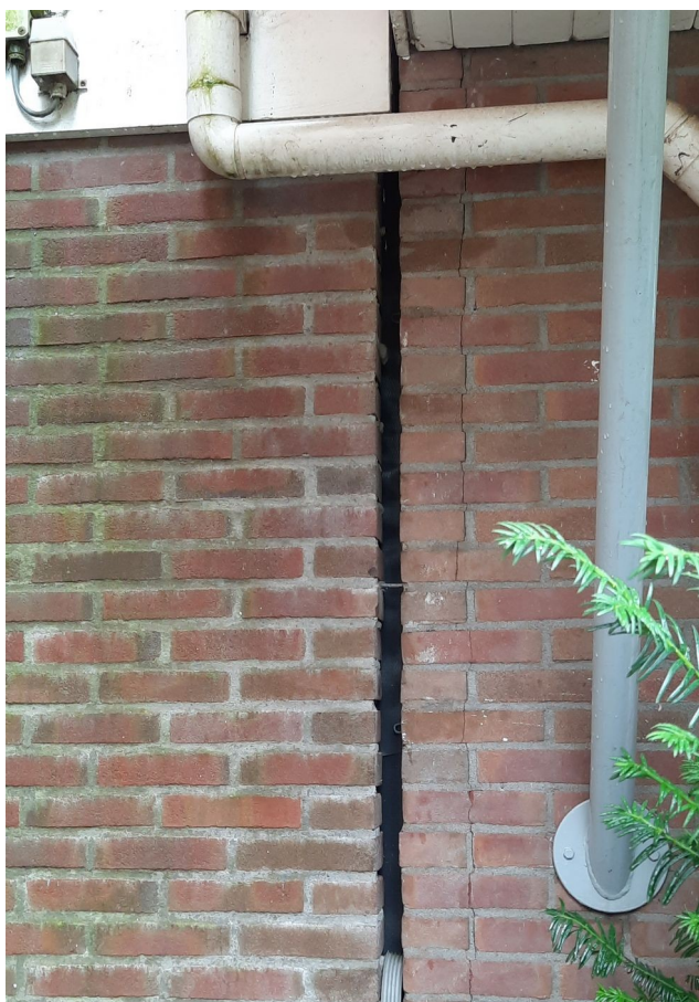
Dilatatie in de gevel van het noordelijke pand aan de Zuidzijde 96. Deze bieden toegang tot eventueel aanwezige verblijfplaatsen van vleermuizen en huismus. Foto: M.M. Bouwmeester | Ecoresult B.V.
