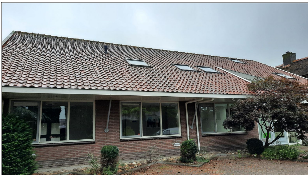
het pannendak van het noordelijke deel van Zuidzijde 96 is geschikt voor vaste rust- en verblijfplaatsen van huismus. Foto: M.M. Bouwmeester | Ecoresult B.V.
