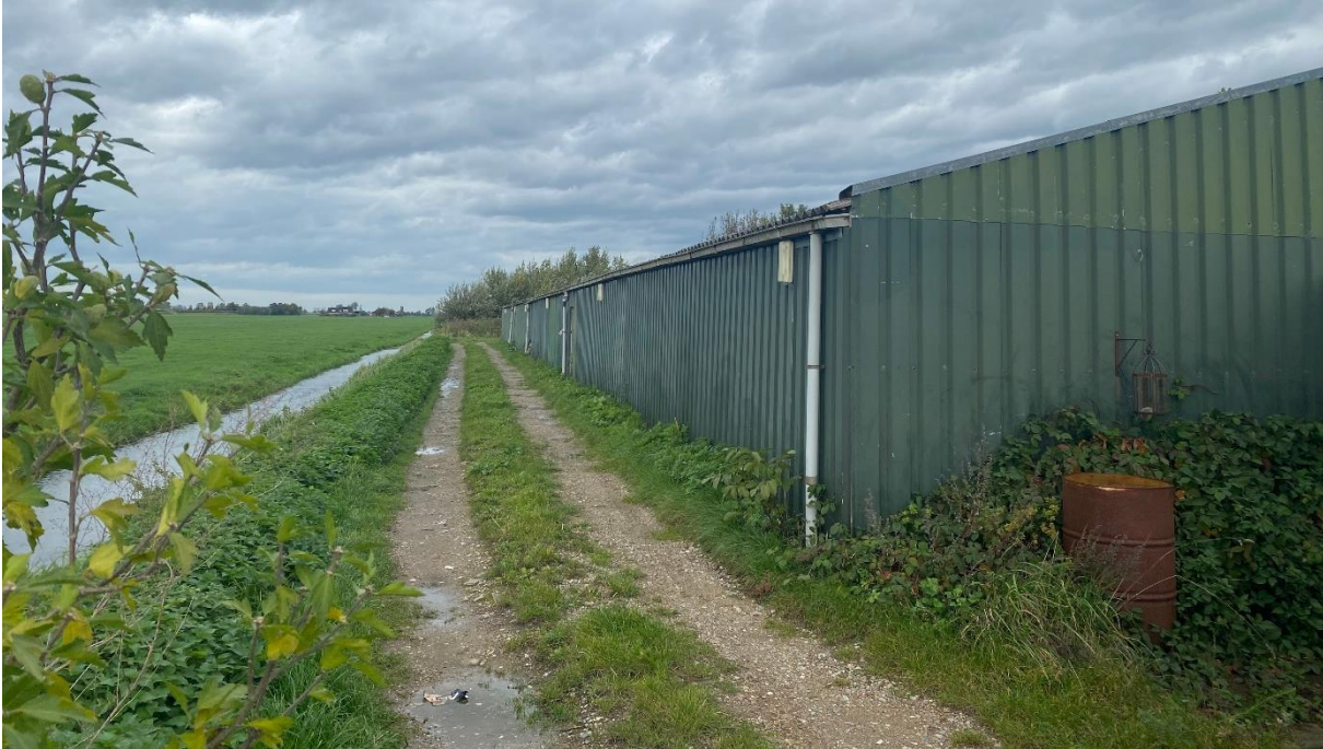
Figuur 2.1 - Zijgevel loods, met pad
