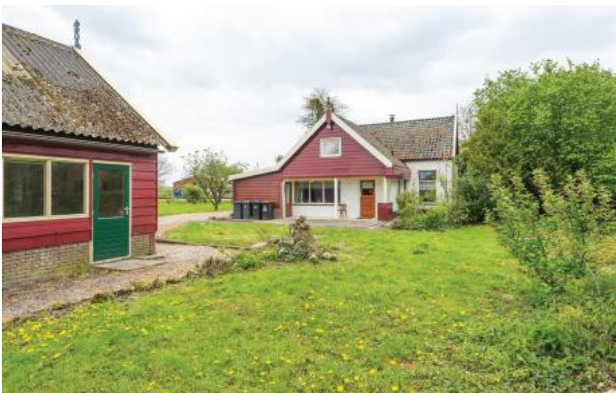
Afbeelding 4: Aanzicht achtergevel bestaande woning en link het bijgebouw
