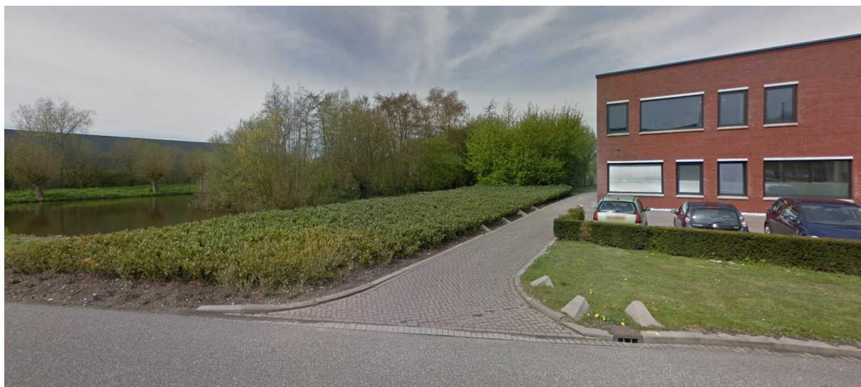
Afbeelding 3: Aanzicht bestaande situatie
