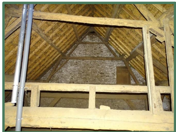
Onderzijde dak en zolder schuurgedeelte
