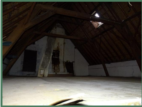
Onderzijde dak en zolder woongedeelte
