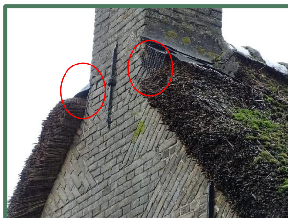
Weringsgaas bij de loodslab tegen de schoorsteen
