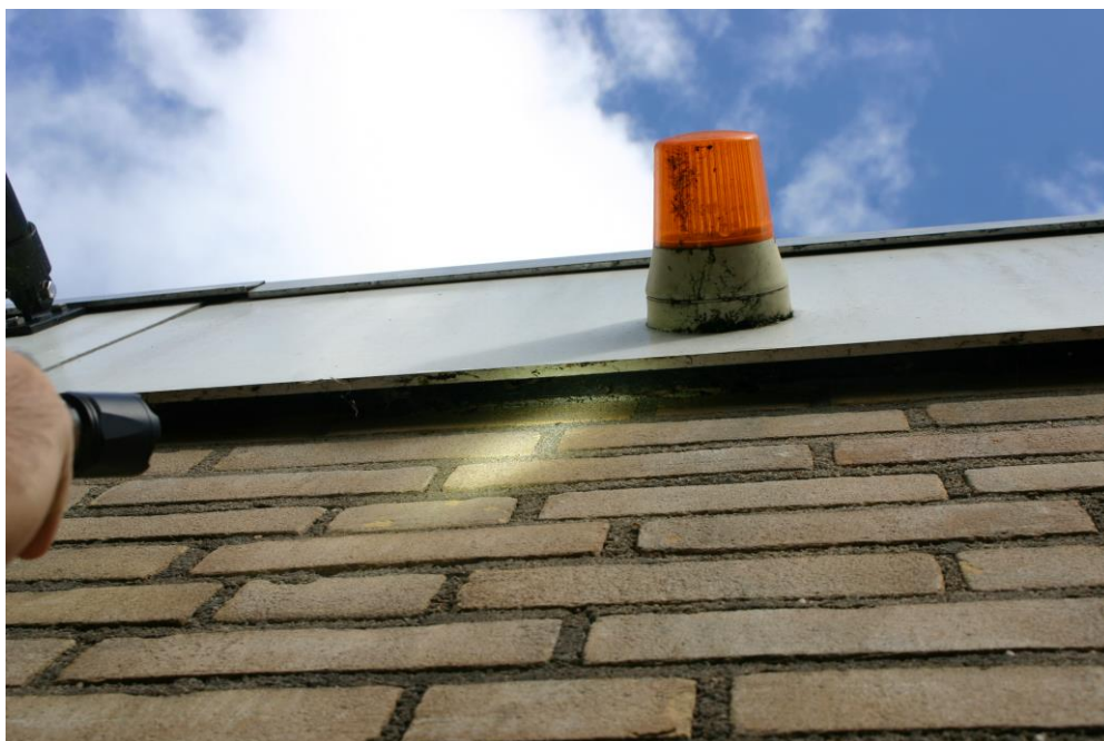
Figuur 4.5.1. De latten waarop de trespa-boeiboorden zijn bevestigd sluiten nauw aan op de gevel.
