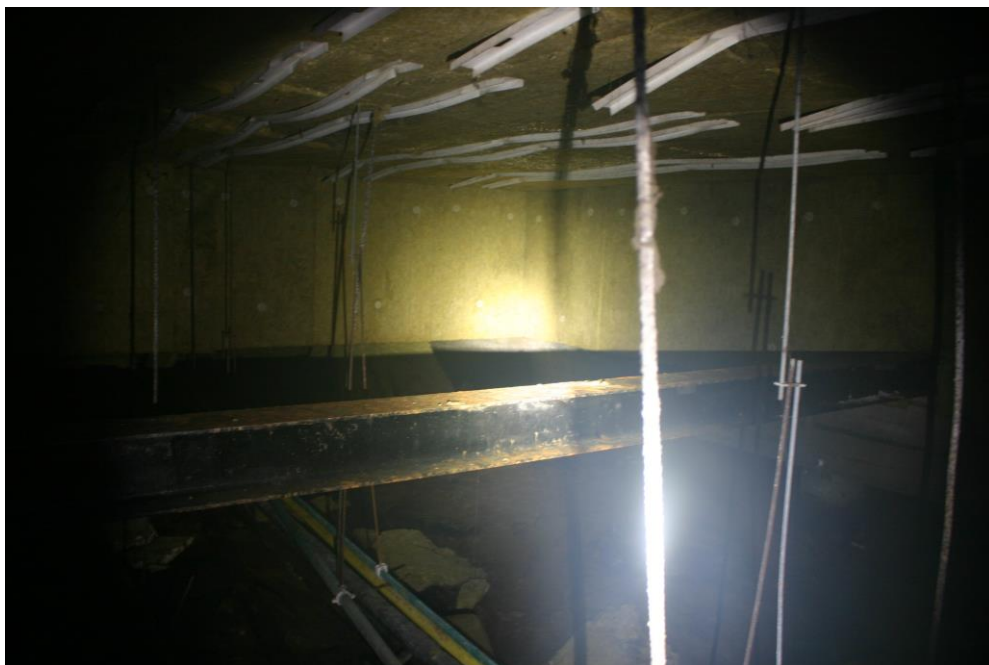
Figuur 4.5.2. De kelder/kruipruimte is aan alle zijden afgesloten met glaswol.
