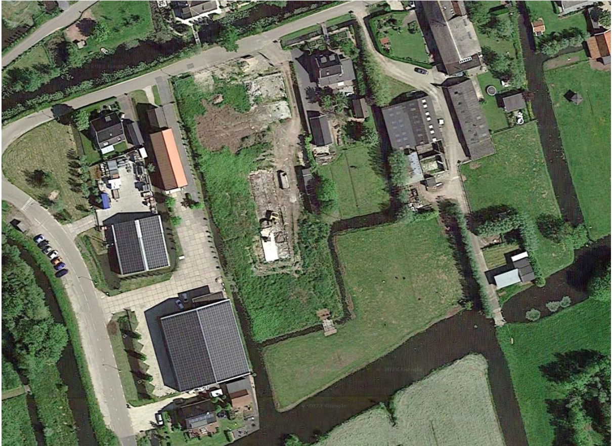
Afbeelding 4: Luchtfoto bestaande situatie
