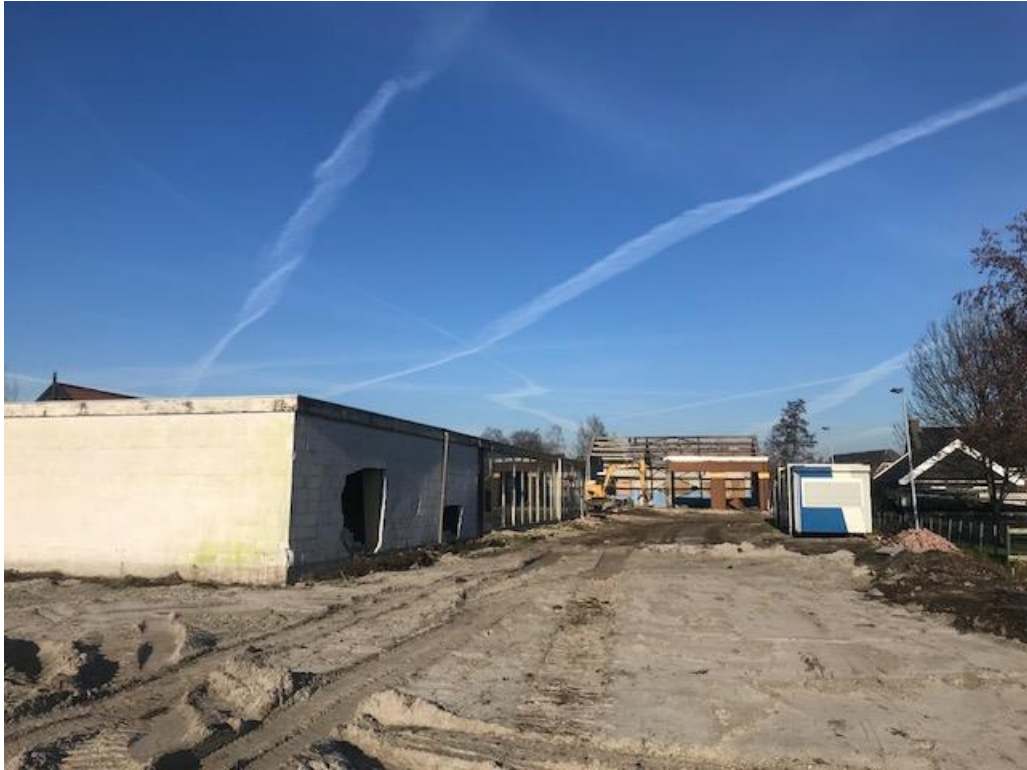
Figuur 3 Het gebouw aan de achterzijde van de planlocatie bestaat uit gemetselde betonblokken met een damwandplaten dak.
