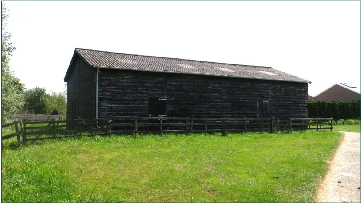
Figuur 5 De grote schuur is tevens opgetrokken uit een simpele constructie.
