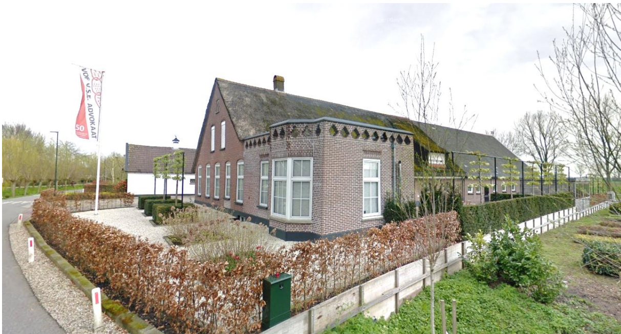
Afbeelding 8: Zicht op het oostelijk deel van het perceel Botersloot 50 te Noordeloos
