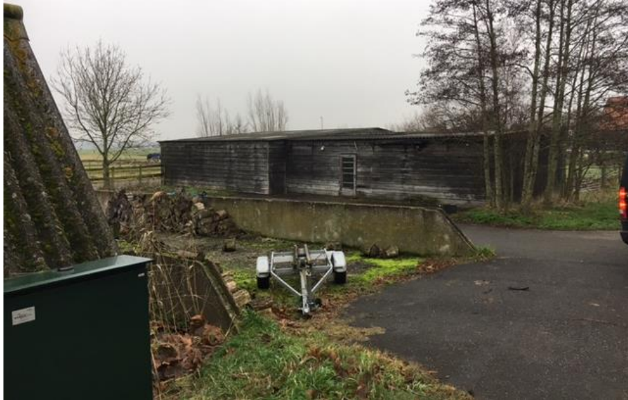
Afbeelding 3: Bestaande vervallen schuren en sleufsilo
