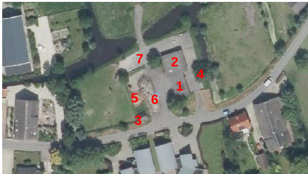
Afbeelding 8: Overzicht bebouwing/verharding perceel Slingelandseweg 11a
