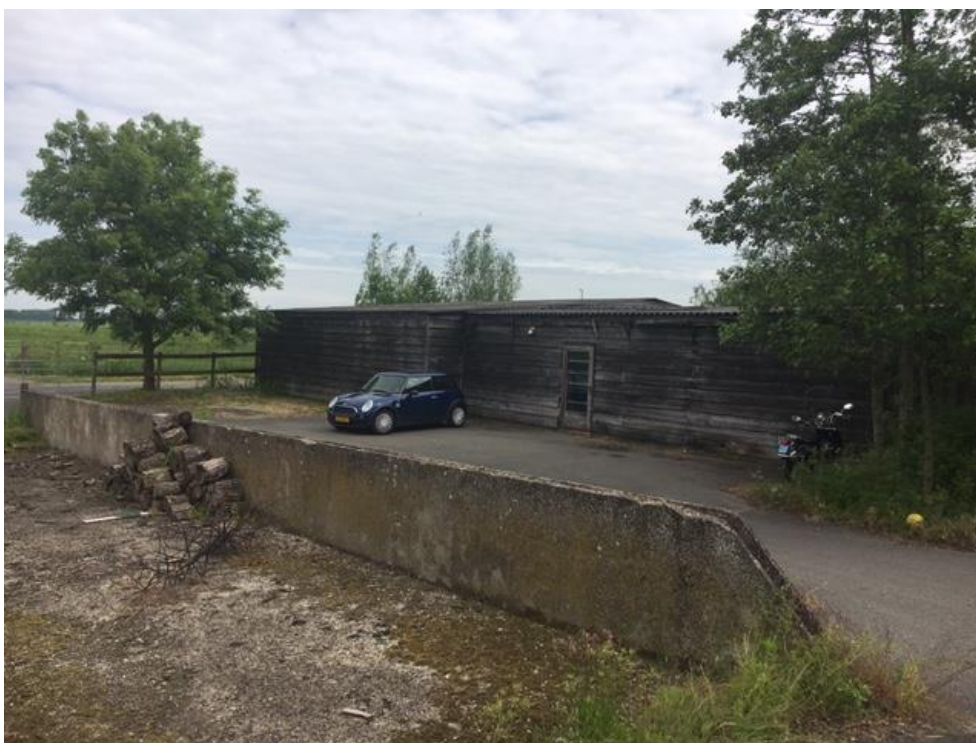
Afbeelding 7: Bestaande vervallen bebouwing
