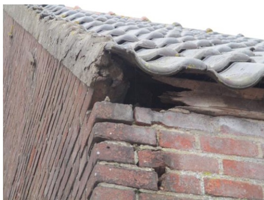
Figuur 4 Opening aan de kopgevel van de schuur
