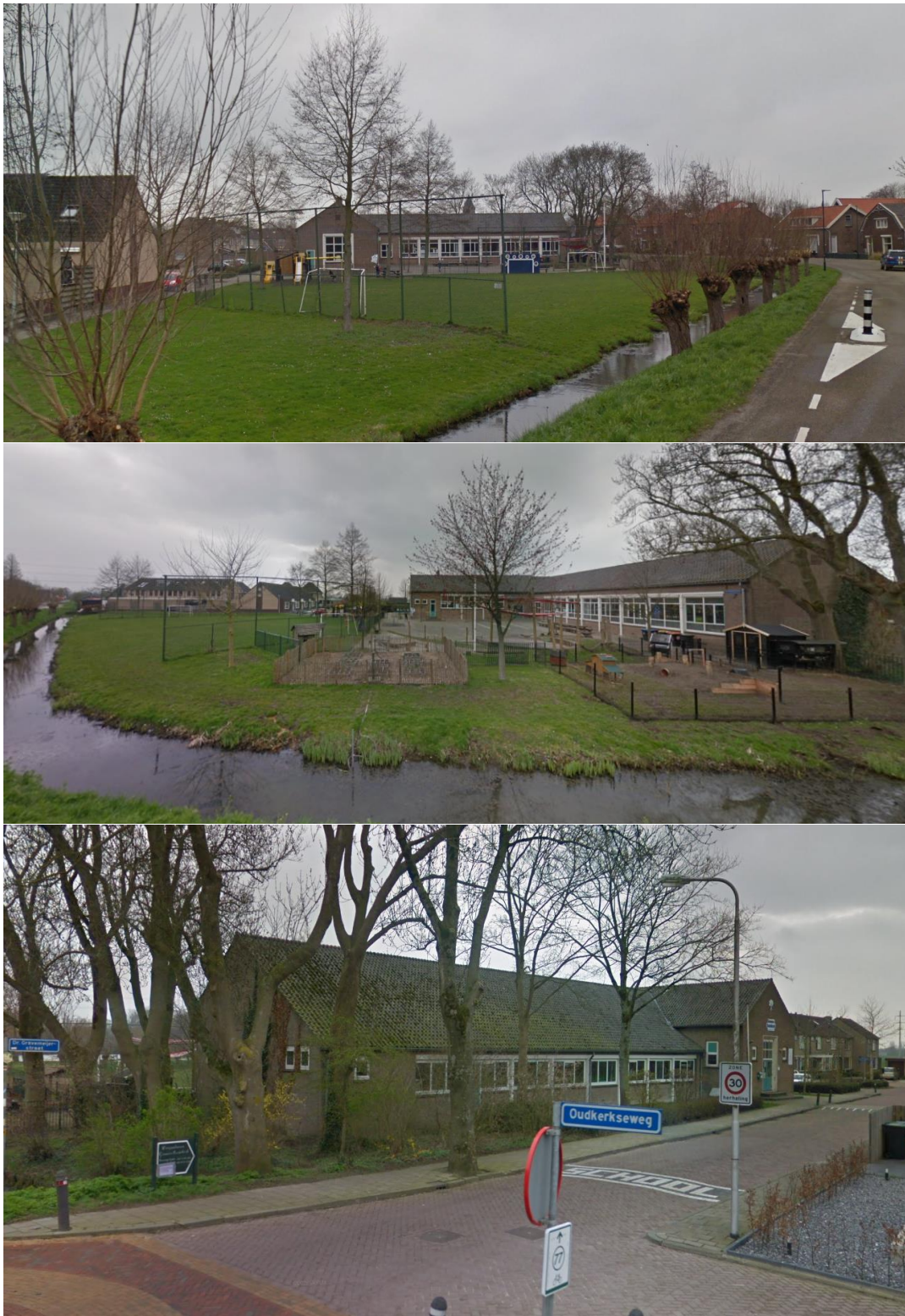
Afbeelding 4: Straatbeeld bestaande situatie
