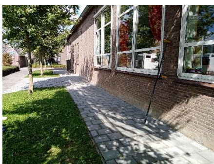
Foto 3: zijkant schoolgebouw (westelijk)
