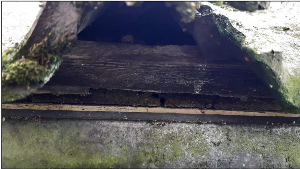
Figuur 5 Opening welke leidt naar de ruimte tussen de dakpannen en het dakbeschot.
