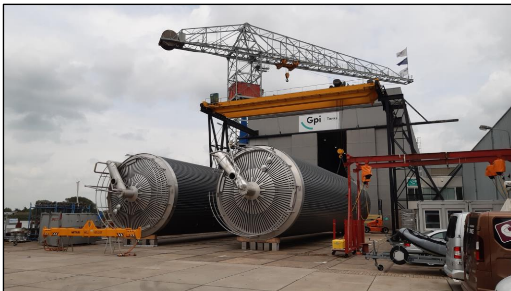
Figuur 2 Overzicht van gebouw I en de opslagtanks welke in deze hal geproduceerd worden en hier tijdelijk aanwezig zijn.
