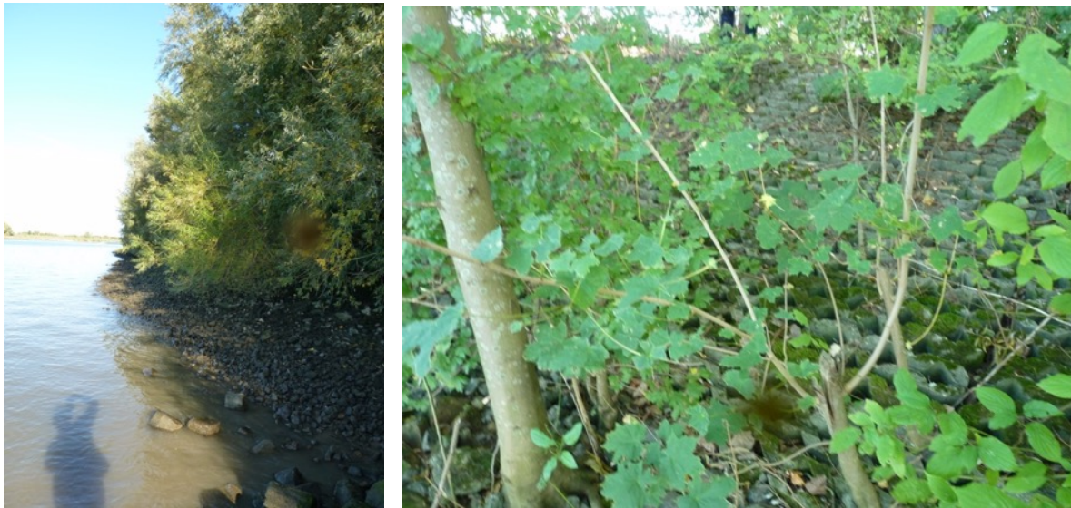
Afbeelding 5 Stenenstrandje en begroeid talud van betonstenen
