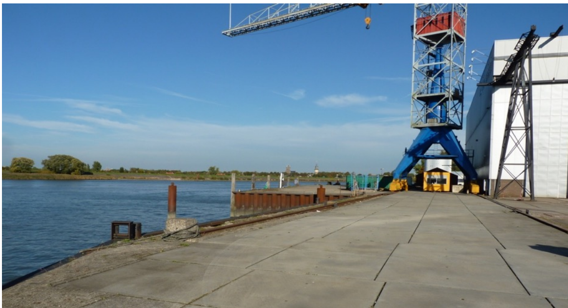
Afbeelding 4: Huidige grote hal, torenkraan met gebouw H en kademuur als dwangpunten voor zichtlijnen.
