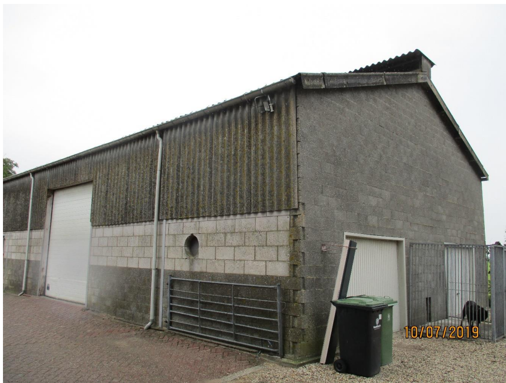
Figuur 3 Loods C.
