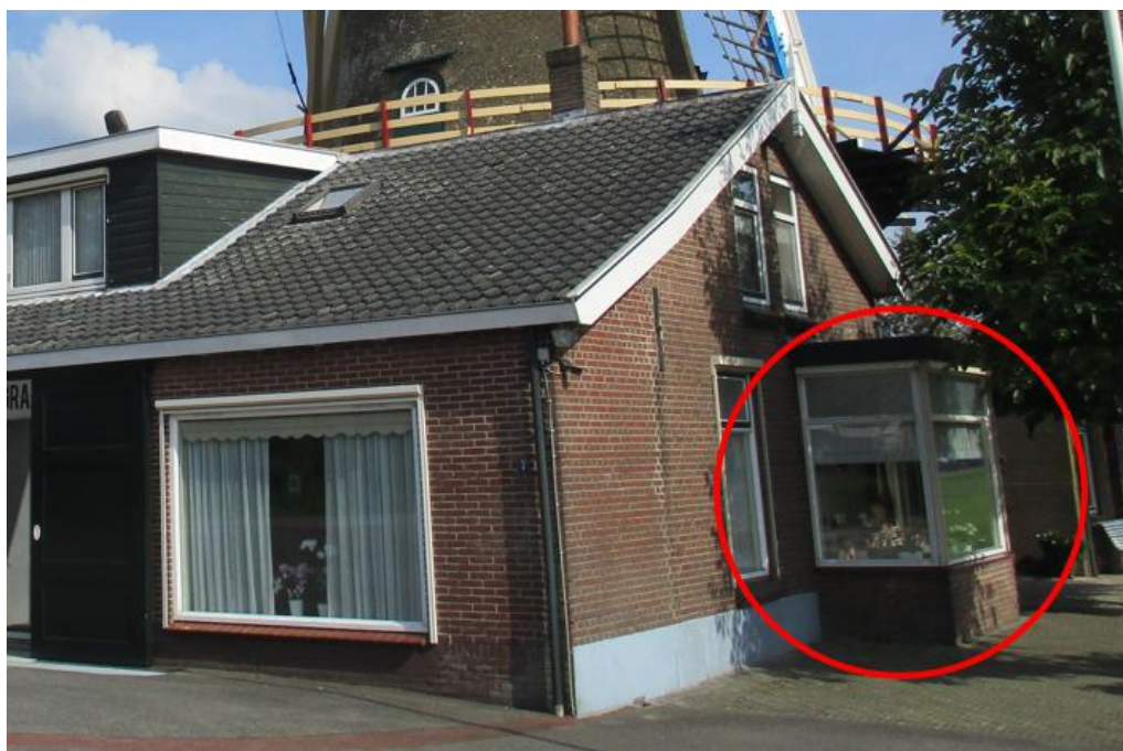
Figuur 3 De te saneren erker aan de westelijke zijde van de woning
