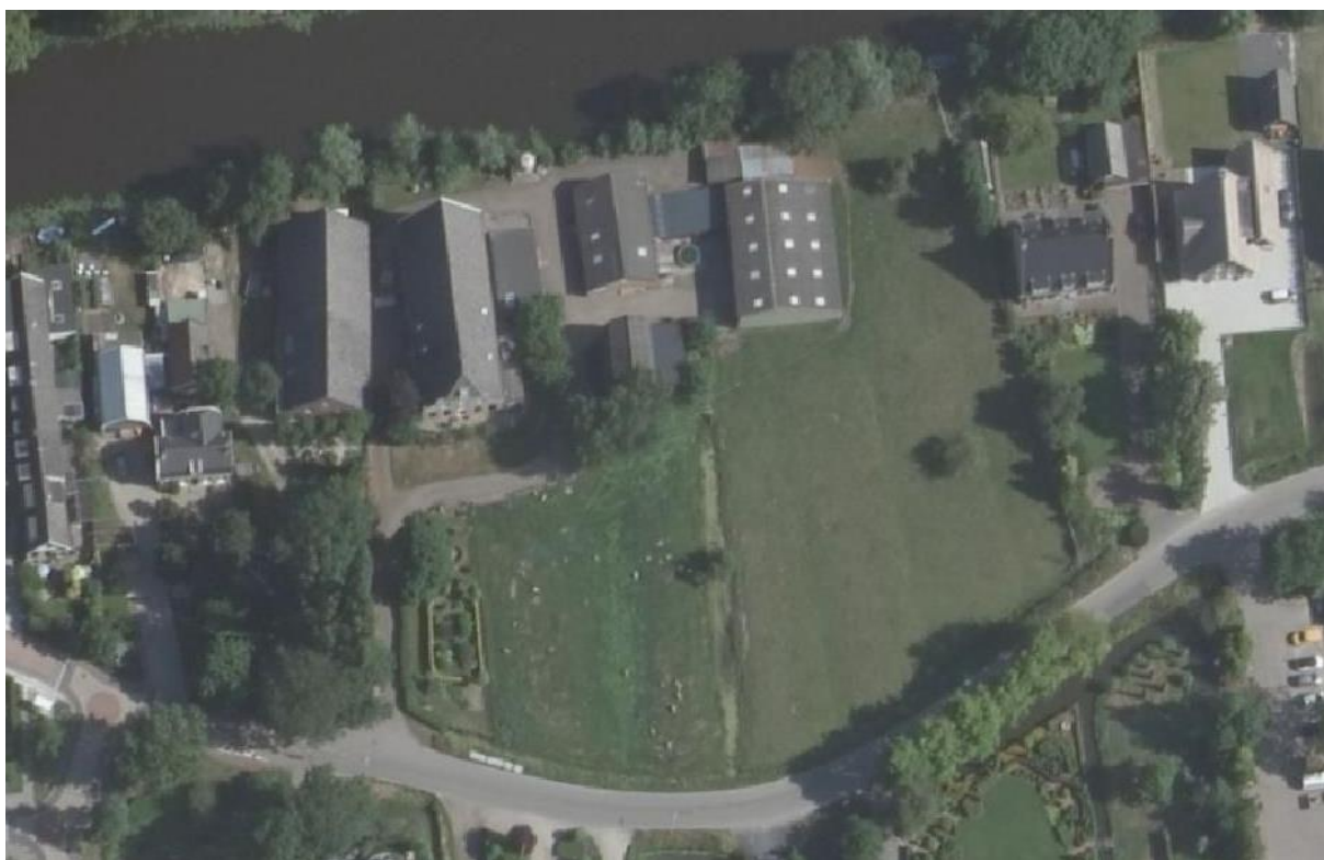
Afbeelding 16: Luchtfoto bestaande situatie
