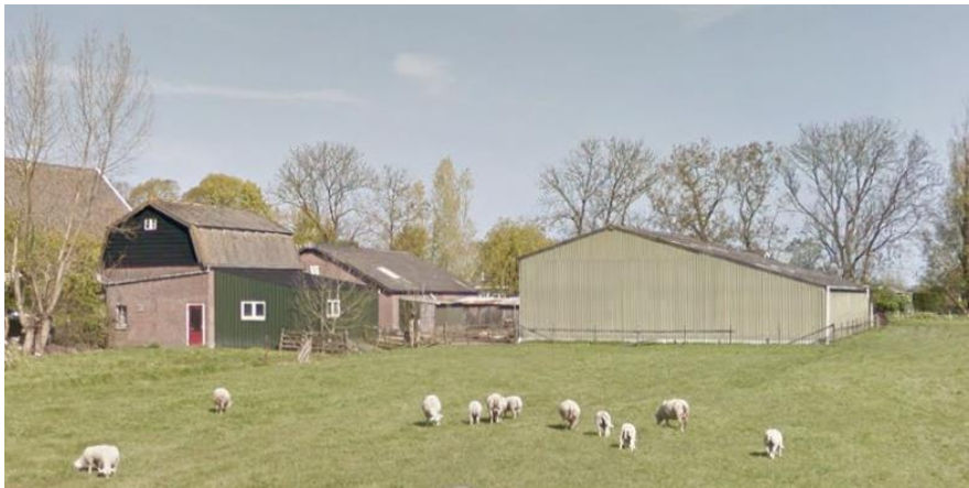
Afbeelding 18: Bestaande agrarische bedrijfsgebouwen deelgebied 1
