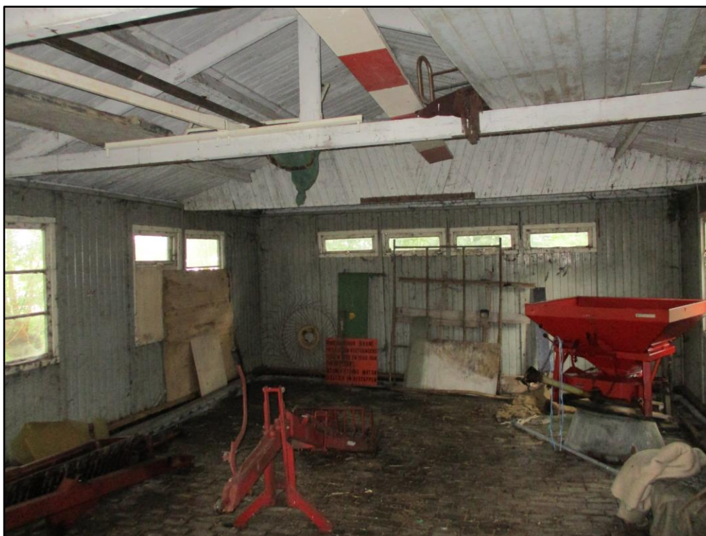
Figuur 2 Binnenzijde van opstal B op de planlocatie.
