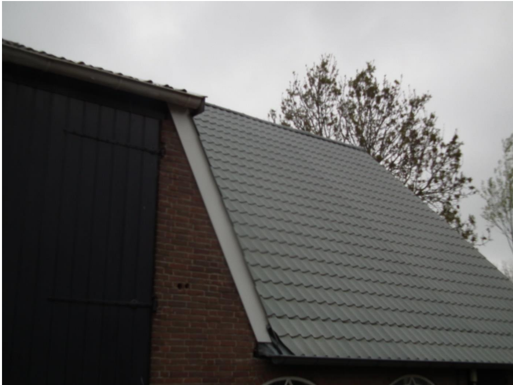
Figuur 3 Een deel van de boerderij beschikt over een dakpanplaten dak.
