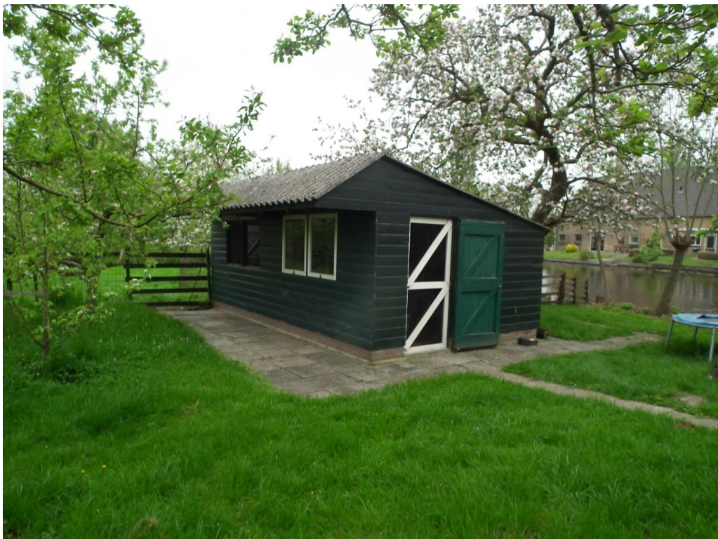
Figuur 4 De overige bijgebouwen betreffen een tuinhuis en een (geiten)stal. De betreffende bebouwing is afgewerkt met rabatdelen en een golflaten dak.
