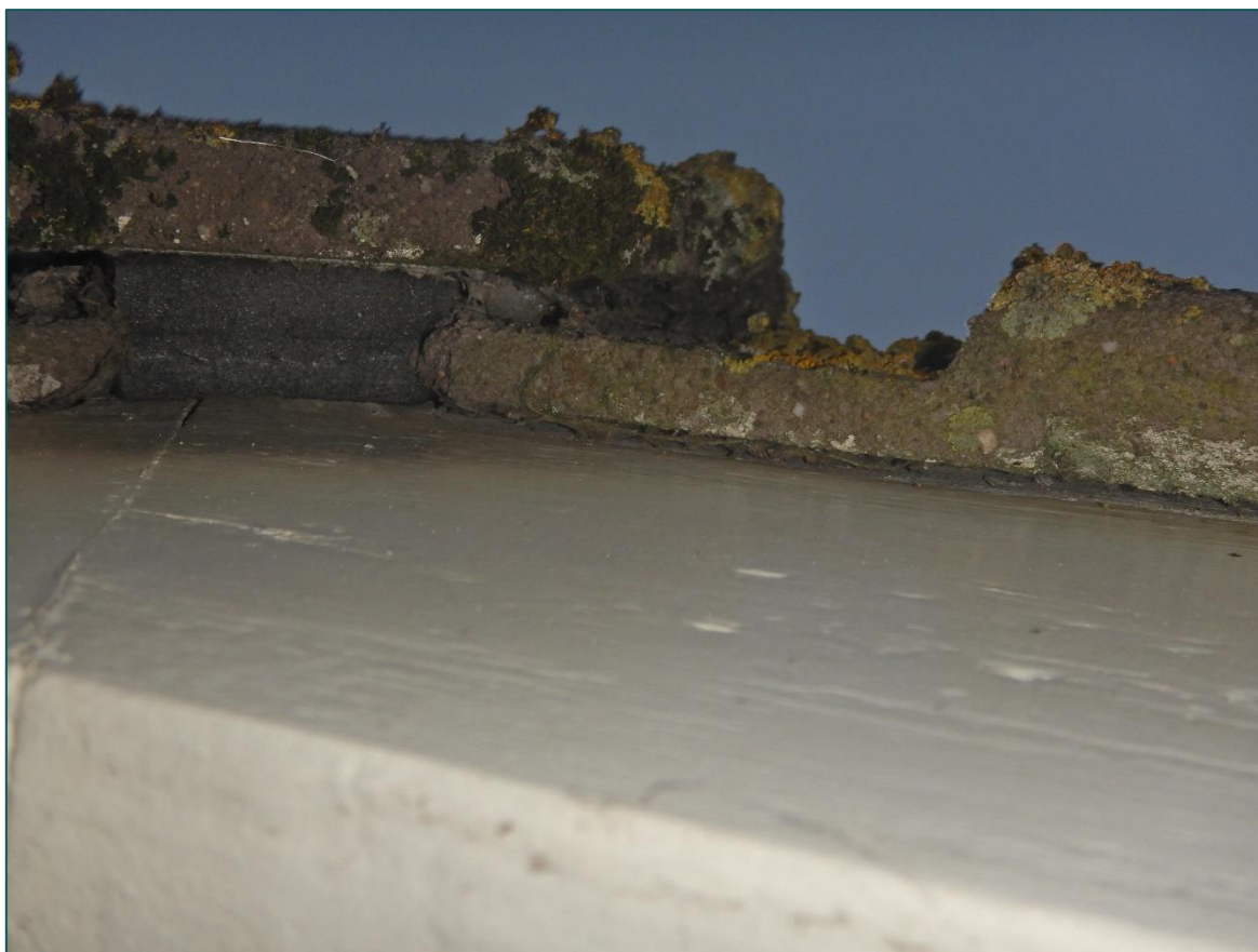
Figuur 3.1 In de nok van de woning zijn isolatiebanden gesitueerd. Deze zorgen ervoor dat er geen toegang mogelijk is voor gebouwbewonende vleermuizen.
