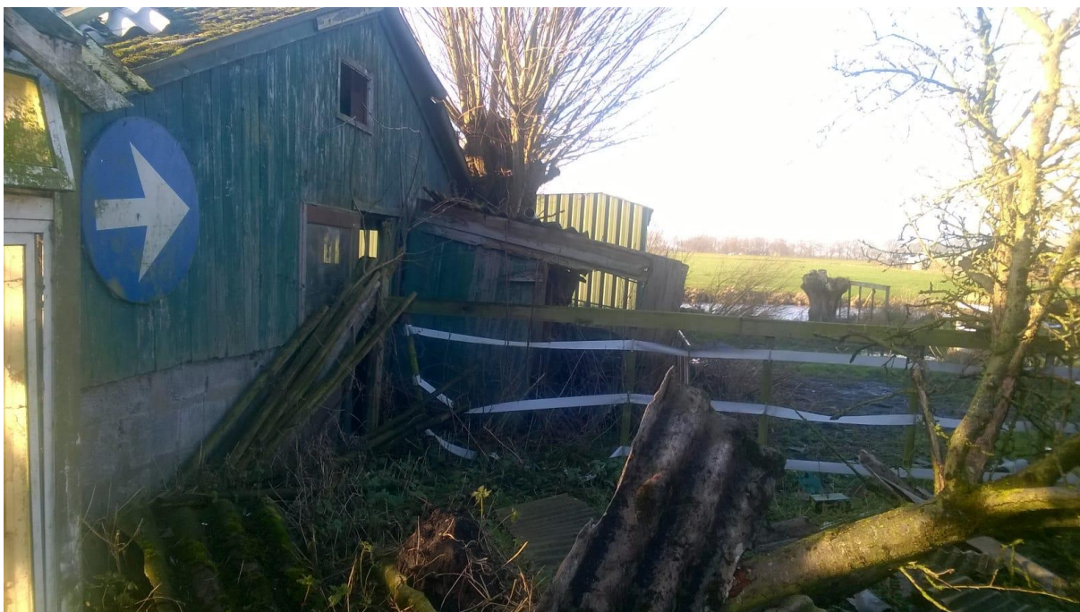
Afbeelding 7: Verouderde schuur op het achtererf
