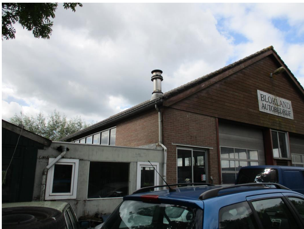
Figuur 2 De loods met garage eraan vast, daarvoor staan verschillende (kapotte) auto's.
