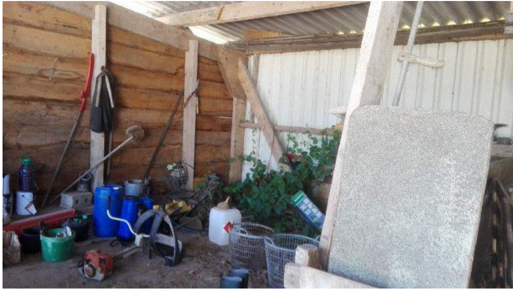
Figuur 4 De overkapping bestaat uit golfplaten en wordt vooral gebruikt voor opslag van materialen.
