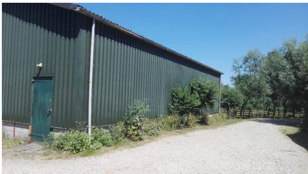
Figuur 3 Naast de woning en boerderij is er tevens een schuur aanwezig die gesloopt zal worden.
