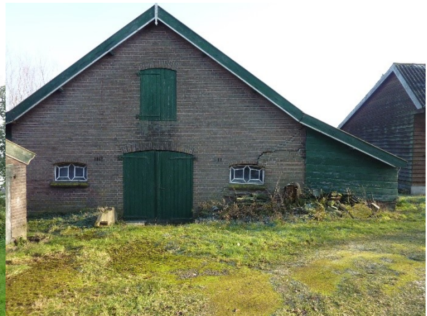
Varkensstal (bj. 1925) op het achter erf. Op de voorgrond asfaltverharding met mos.
