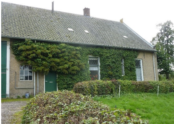
Aanzicht zijgevel woongedeelte aan de noordzijde. Boerderij ligt op terp. Links zie de asfaltverharding. Bij het woongedeelte enige verharding met kiezels aanwezig.
