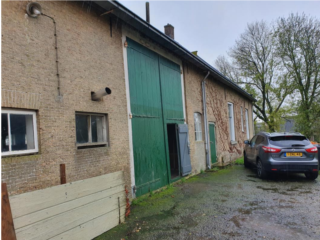
Figuur 3 De woonboerderij op de planlocatie, opgetrokken uit gemetselde muren zonder spouw en een pannendak geplaatst op voormalig rieten dak.
