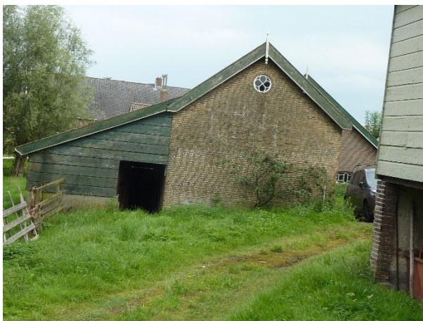
Foto van het geasfalteerde pad in de richting van bijgebouw kippen en kalverstal (bj. 1910). Zie rechts de loods met het souterrain.
