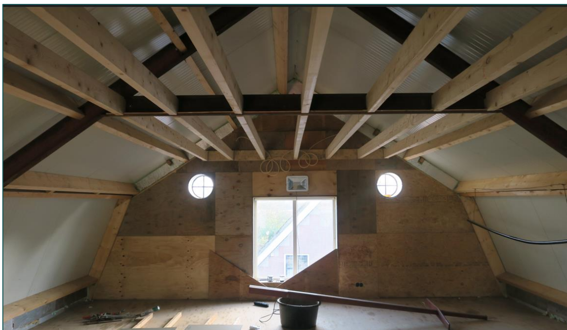
Figuur 2 Het bedrijfspand is voorzien van nieuwe isolatie en een dakbeschot.
