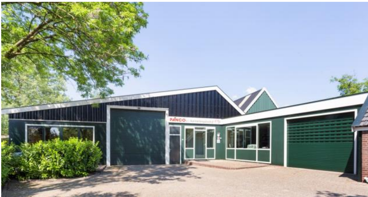
Afbeelding 5: Schuur en bedrijfsloods op het achtererf Noordzijde 103
