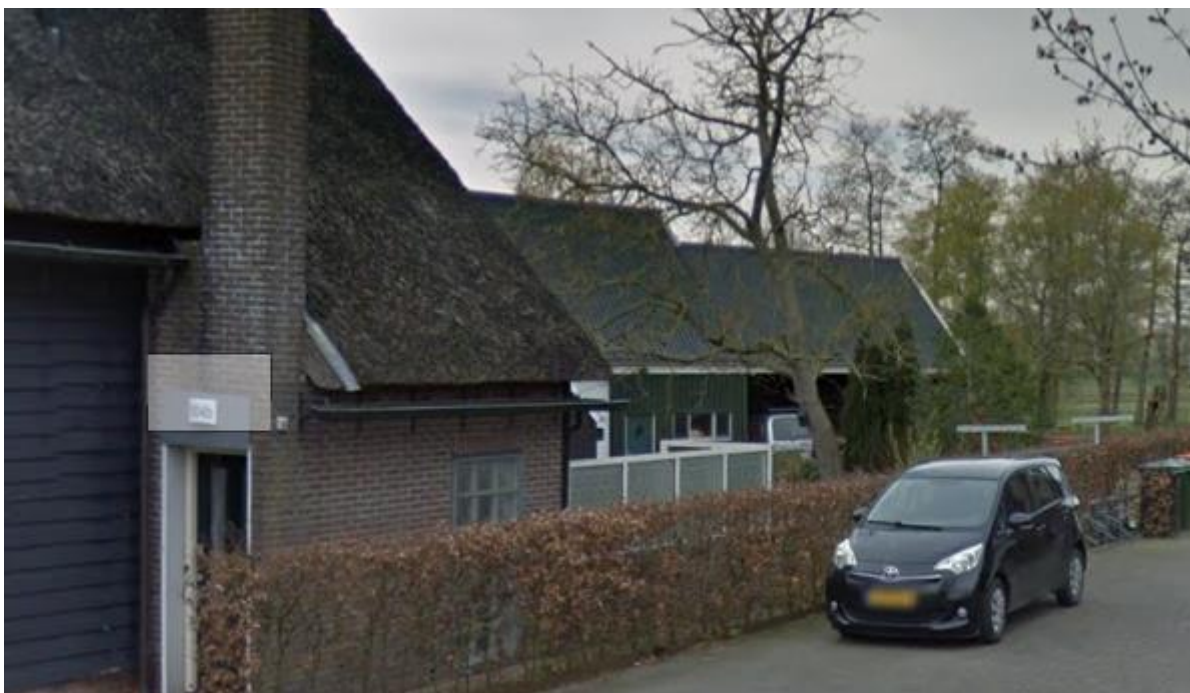
Afbeelding 7: Zicht op bijgebouwen op het achtererf Noordzijde 104
