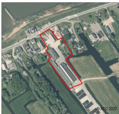
Luchtfoto huidige situatie
