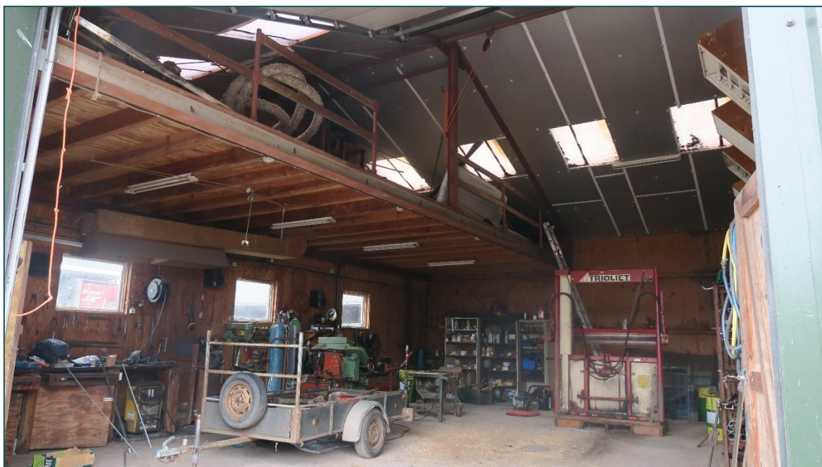
Figuur 5 Binnenzijde van de werktuigenberging (zuidelijke deel).
