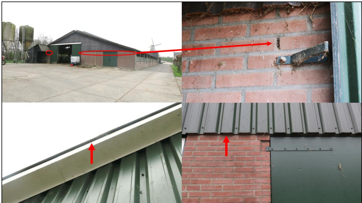
Figuur 3.2 De spouw van de melkveestal (2) is toegankelijk middels de open stootvoegen aan de zuidoostelijke gevel (foto's boven). Tevens is de spouw en/of open dakruimte toegankelijk via de kierende golfplaten bij het overstek (links onder) en de damwandplaten tegen de gemetselde muren (rechts onder).
