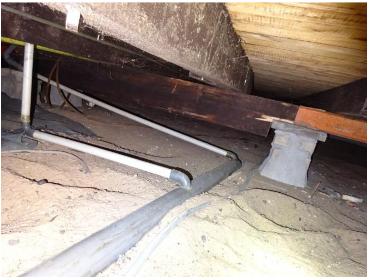
Afbeelding 21: Houten vloer van de woning op gemetselde poeren met voetplaat
