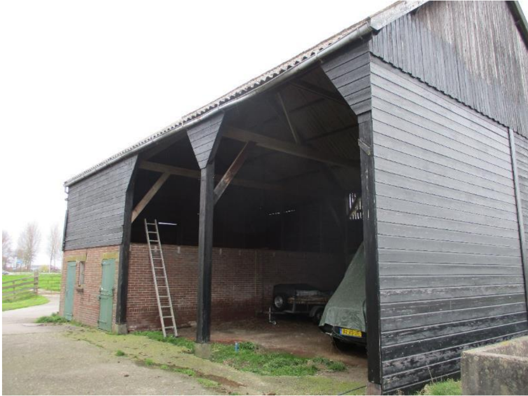
Figuur 3 Schuur A is een kapschuur opgetrokken uit gemetselde en houten muren
