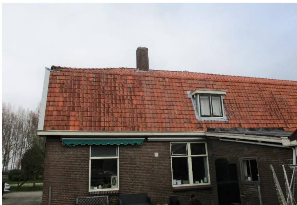
Figuur 2 De vrijstaande woning aan de Nieuwendijk 19 is opgetrokken uit gemetselde muren met spouw en zadeldak met dakpannen.
