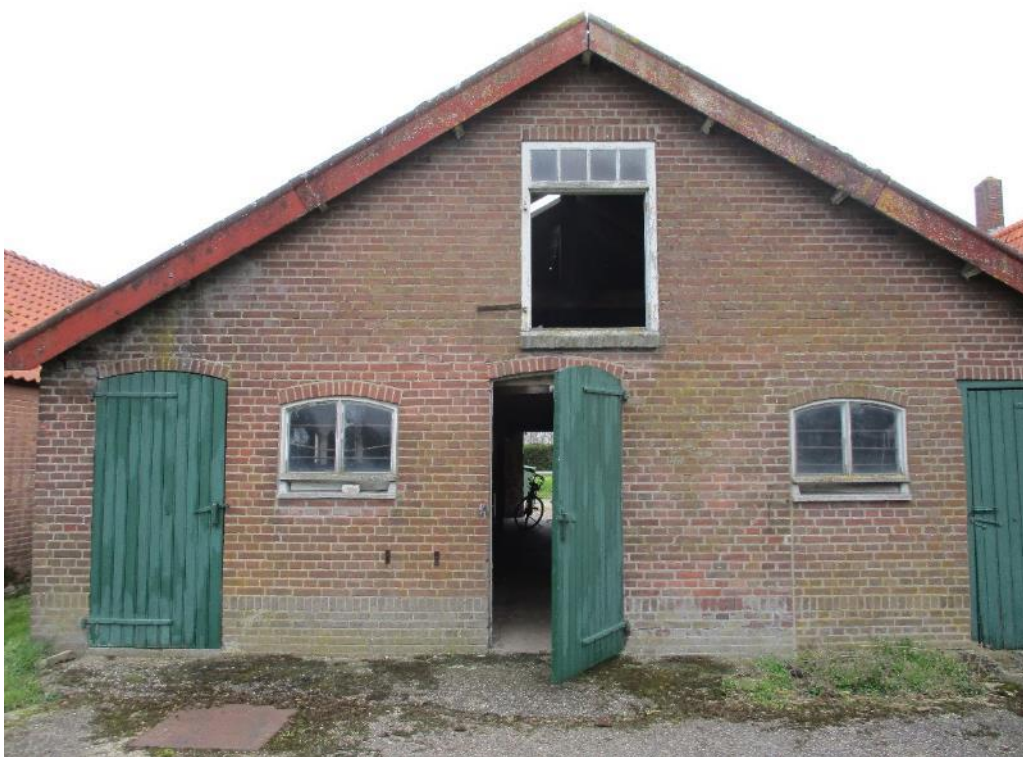
Figuur 6 Schuur C bestaat uit gemetselde muren zonder spouw en een zadeldak met golfplaten
