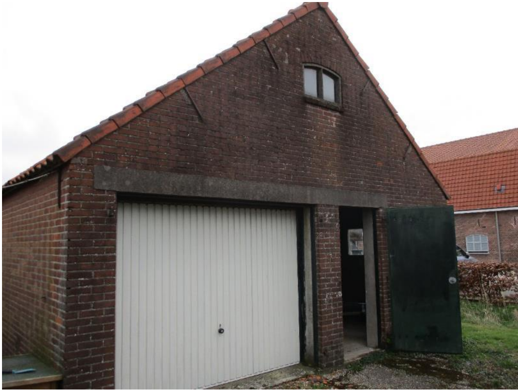
Figuur 7 Schuur E bestaat uit gemetselde muren met spouw en een zadeldak met dakpannen.
