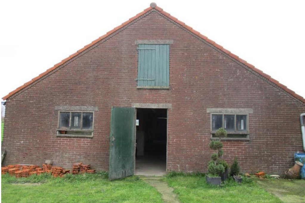
Figuur 5 Schuur B is een voormalige varkensstal opgetrokken uit gemetselde muren met spouw en zadeldak met dakpannen.
