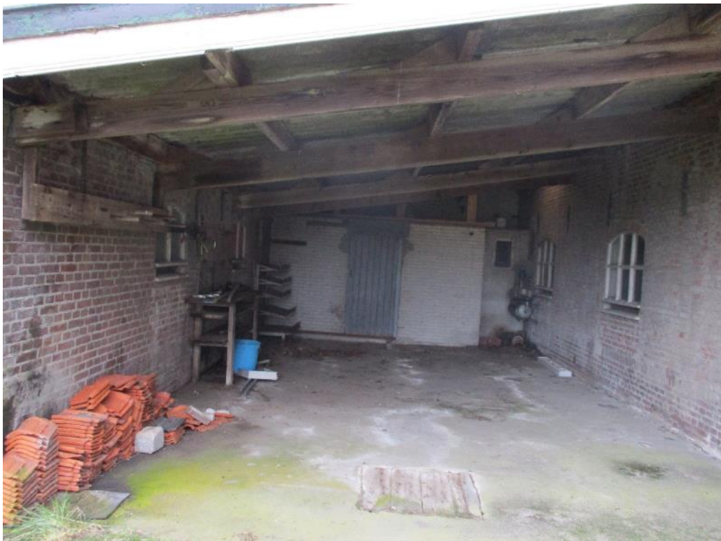
Figuur 8 Overkapping E is gebouwd tussen de vrijstaande woning en schuur C en bestaat uit golfplaten en een houten dakconstructie.
