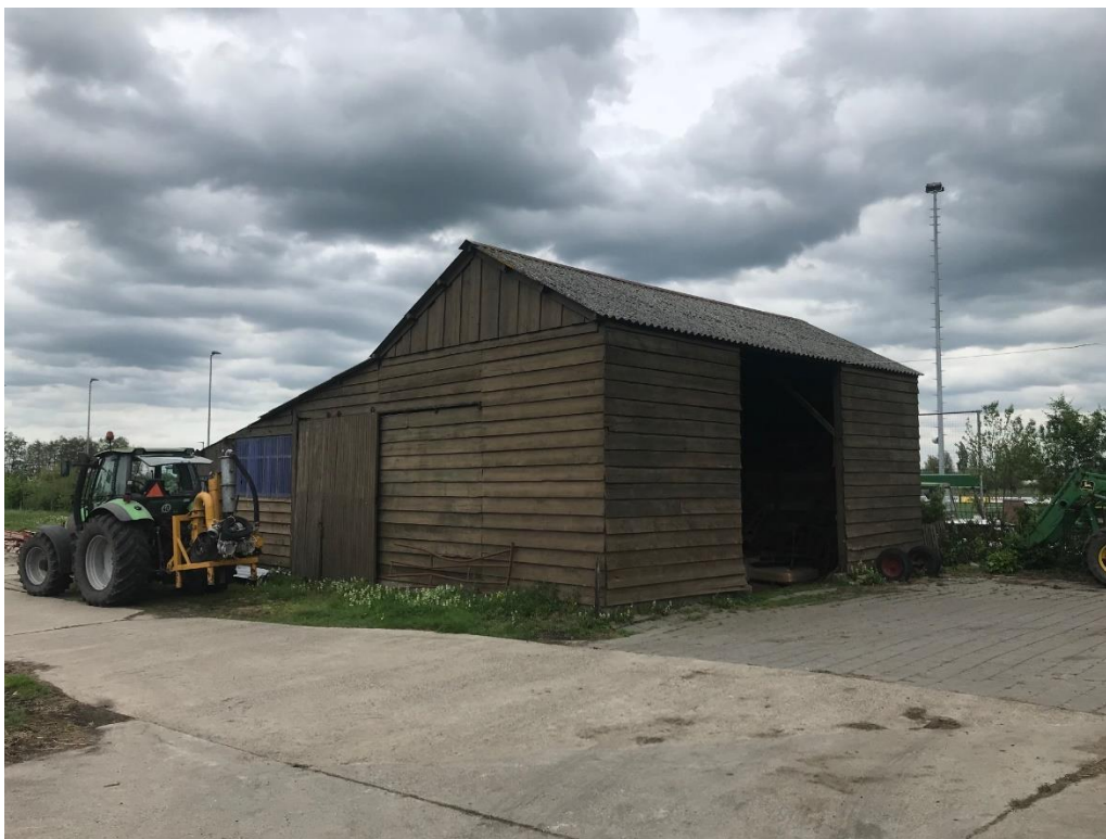
Figuur 1 Schuur A. In de schuur zijn kippenrennen aanwezig.
