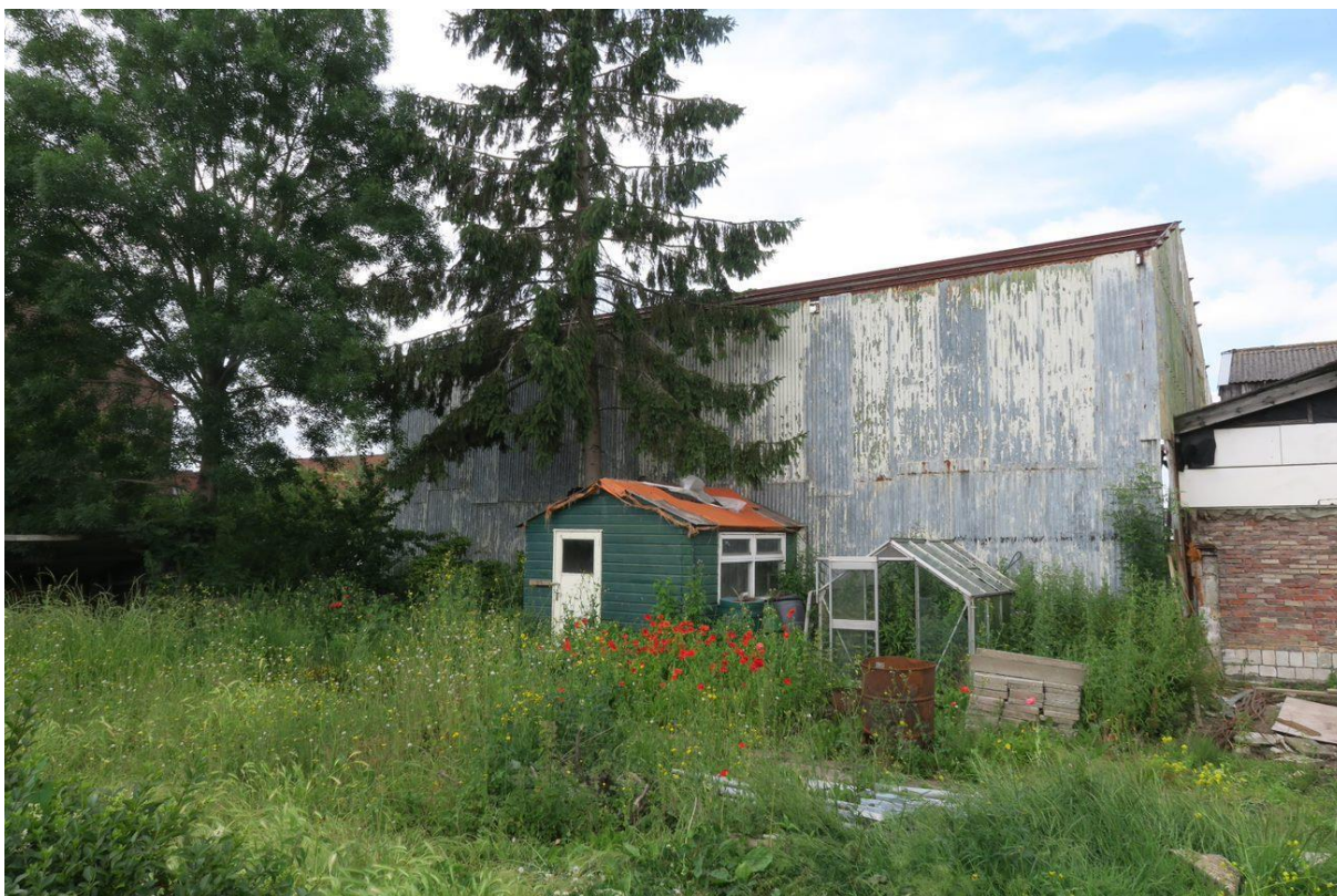
Afbeelding 8: Zicht op de te slopen golfplaten bedrijfsgebouw
