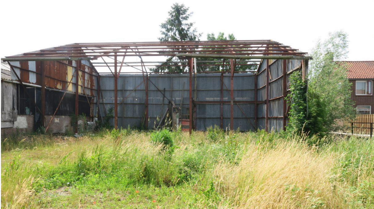
Afbeelding 7: Verouderde bedrijfsloods aan de zuidzijde van het plangebied
